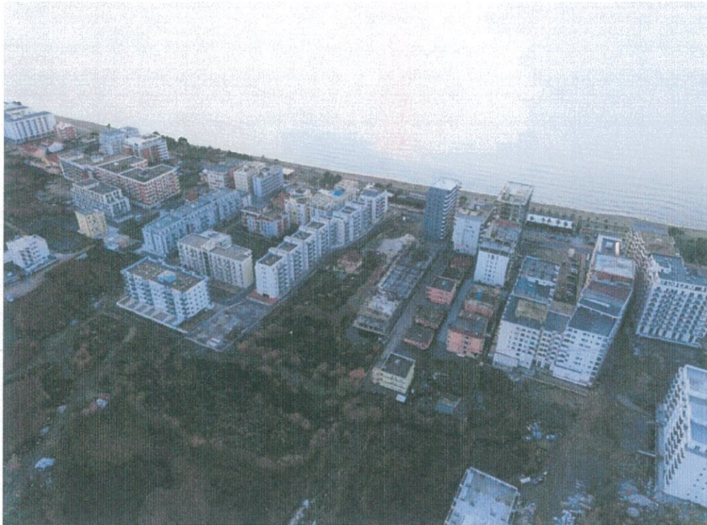
Fig. 7 - Foto të gjendjes ekzistuese të truallit
