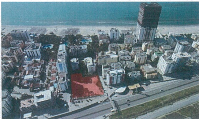
Fig.2 Foto e sheshit të ndërtimit.
