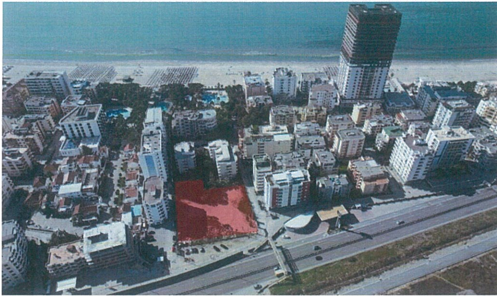
Fig.7 Foto e sheshit të ndërtimit.
